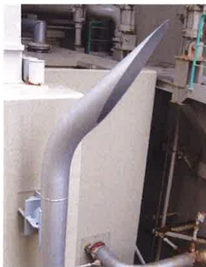
図 1 タービン動補助給水ポンプ蒸気大気放出管の設置状況
