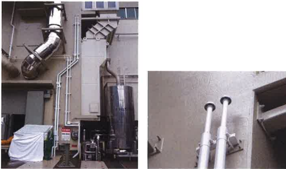
図 2 燃料油貯油そうベント管の外観写真（右は拡大写真）
