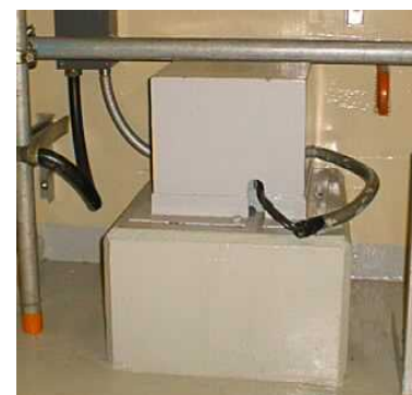
(参考) 6号機の既設地震計
