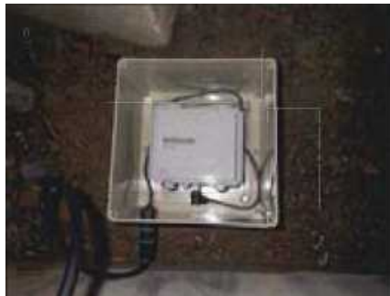
① 1階レベル (北西側構台下)
