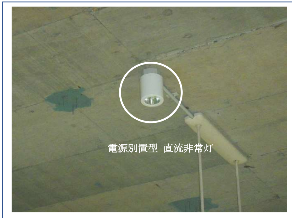
第 1 図 電源別置型の直流非常灯の設置イメージ
