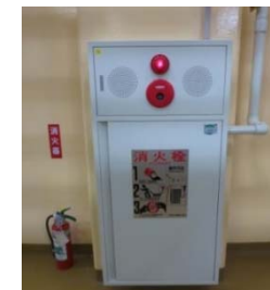
消火器及び消火栓
