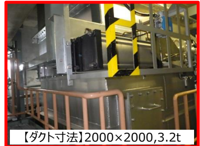
廃棄物処理建物換気系測定箇所（例）
