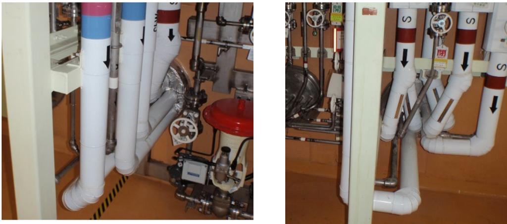
図-1 配管分岐室におけるセル貫通部の蒸気配管等の設置状況
