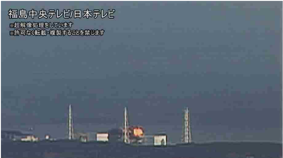
図 7-9 3号機における水素爆発時の原子炉建屋上部の火炎の状況 6/60 秒
