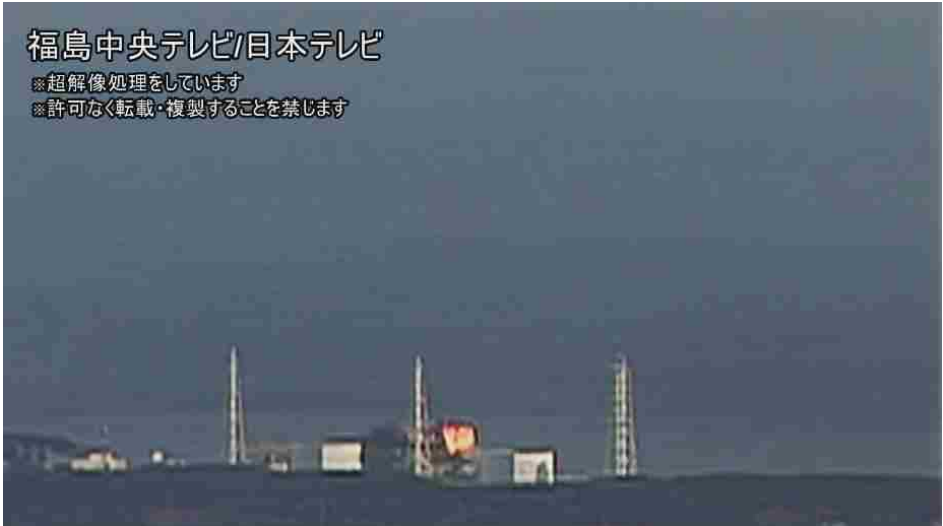
図 7-8 3号機における水素爆発時の原子炉建屋上部の火炎の状況 5/60 秒
