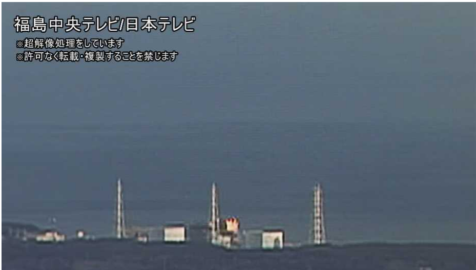
図 7-4 3号機における水素爆発時の原子炉建屋上部の火炎の状況 1/60 秒
