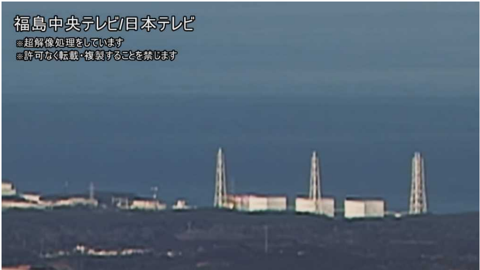
図6—2 1号機における水素爆発時の原子炉建屋上部の火炎の状況 0/60秒
