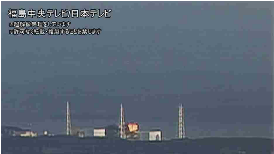
図 7-7 3号機における水素爆発時の原子炉建屋上部の火炎の状況 4/60 秒
