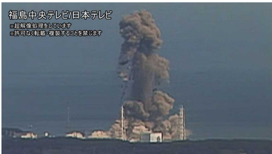
図5—5 3号機の水素爆発における噴煙等の状況 540/60秒
