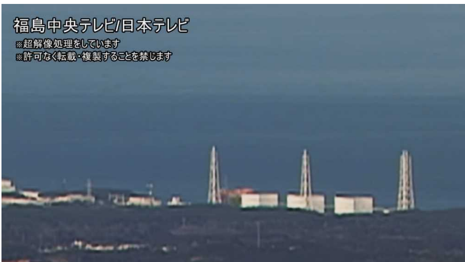
図6—4 1号機における水素爆発時の原子炉建屋上部の火炎の状況 2/60秒
