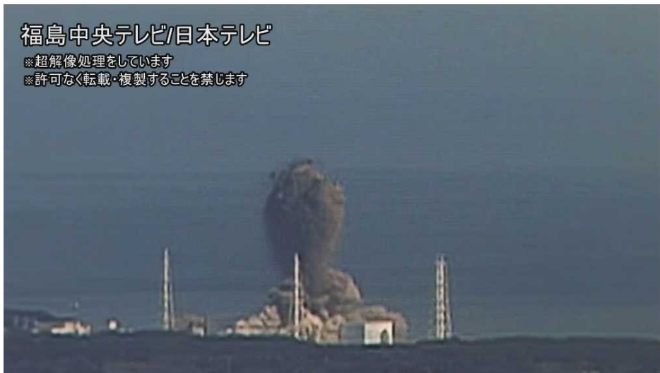
図5—4 3号機の水素爆発における噴煙等の状況 300/60秒
