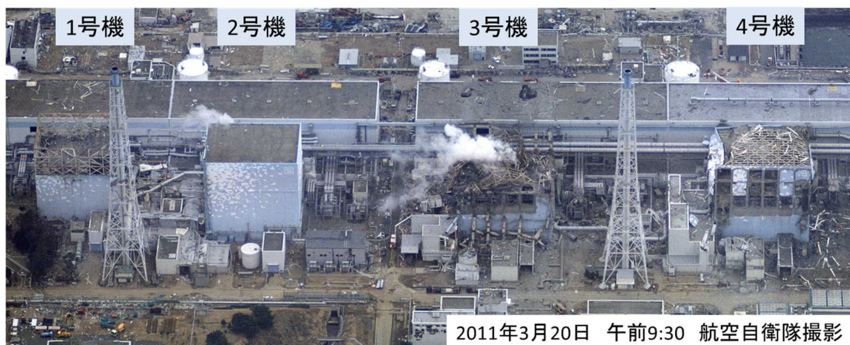
図1 1-4号機の東京電力福島第一原子力発電所事故後直後の外観
