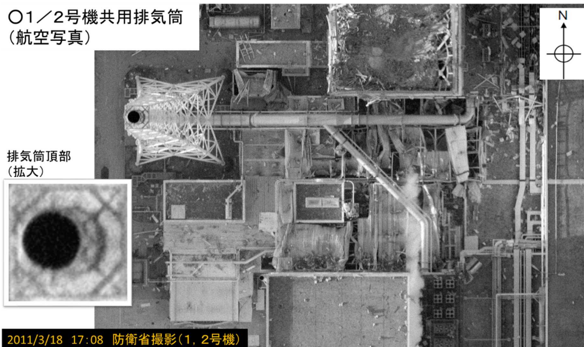
図5 1/2号機 SGTS 配管系の建屋外の状況 (航空写真)
