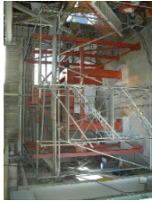
溶融炉架台の設置
