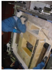
気相部耐火レンガの据付
