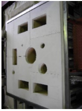
断熱膨張吸収材の施工
