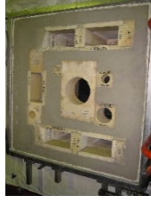
断熱キャスタブルの施工
