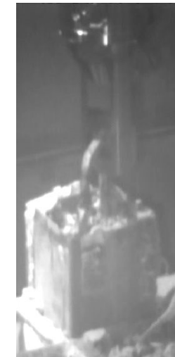
吊り上げ状況
