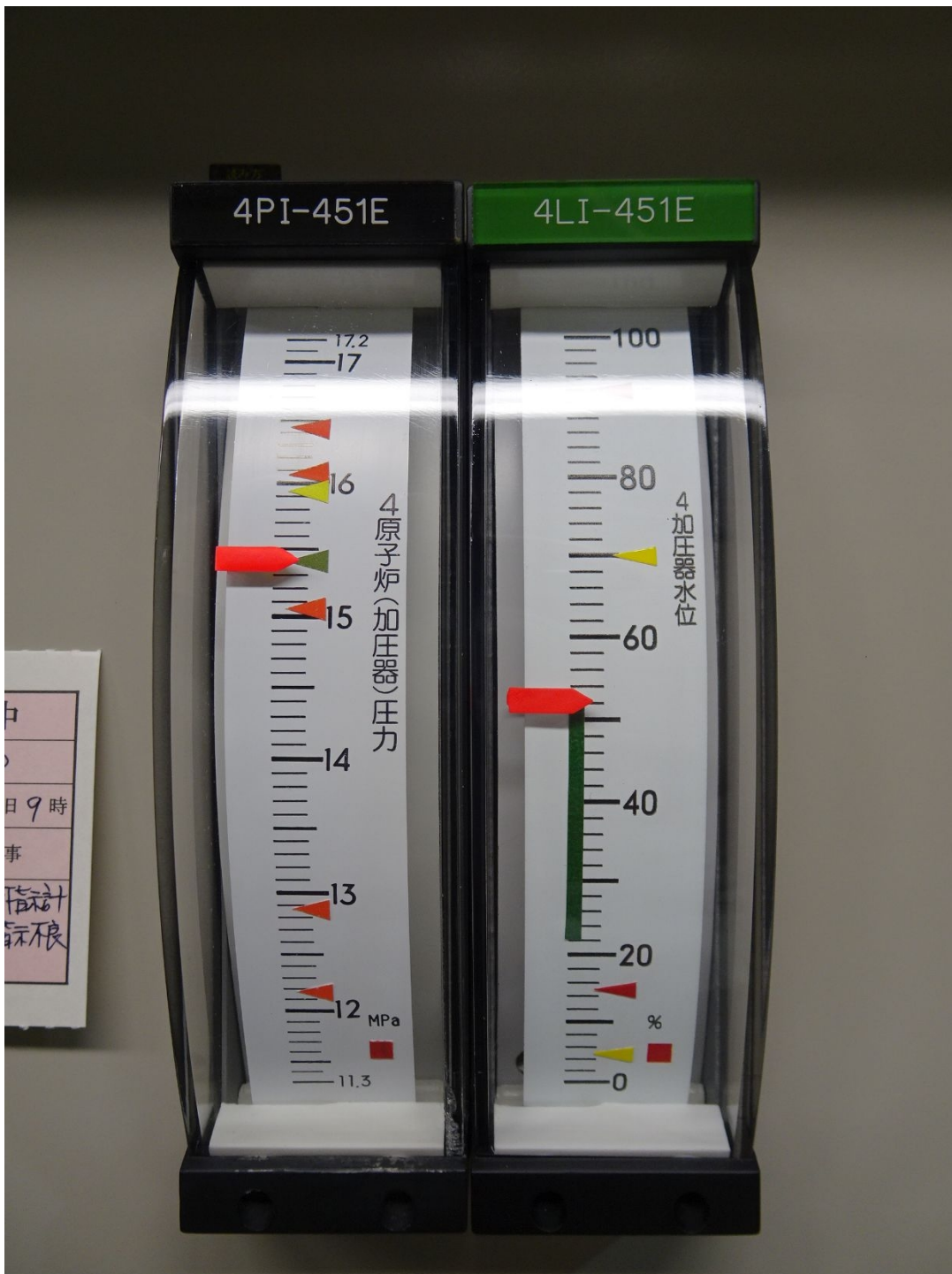
現地压力指示計写真（取替後）
