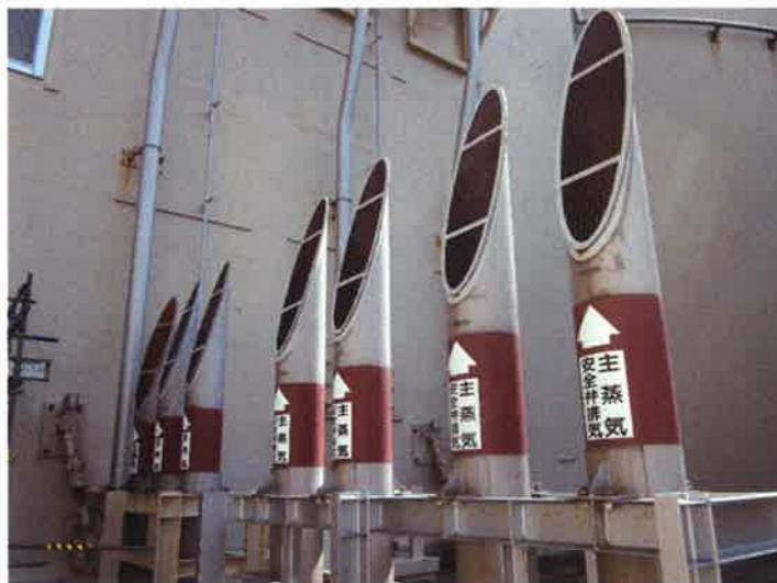
図3 主蒸気安全弁（排気管）の設置状況
