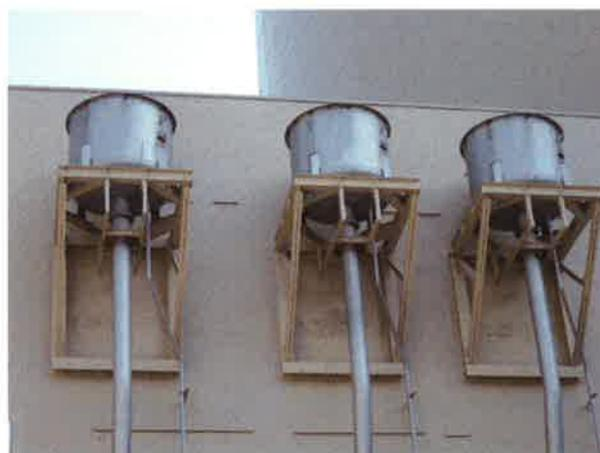
図3 主蒸気逃がし弁消音器の設置状況
