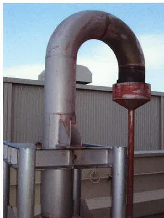
図 1 タービン動補助給水ポンプ蒸気大気放出管の設置状況
