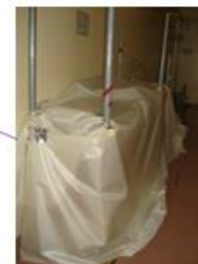
資材(パイプ、チオックス、段ボール等) 【防災シート】
