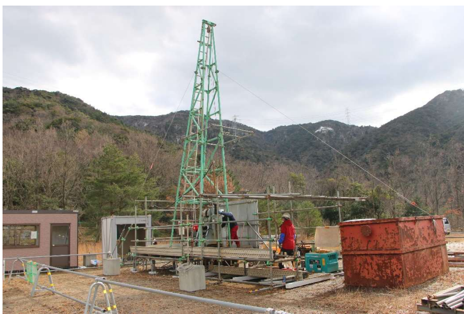
図2 ボーリング作業(2021年1月18日撮影)
