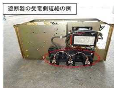
図 4-11 遮断器の短絡箇所 (MCC 試験時)
