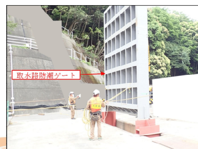
② 所定位置から地切り後、取水口角落し開口部に挿入
