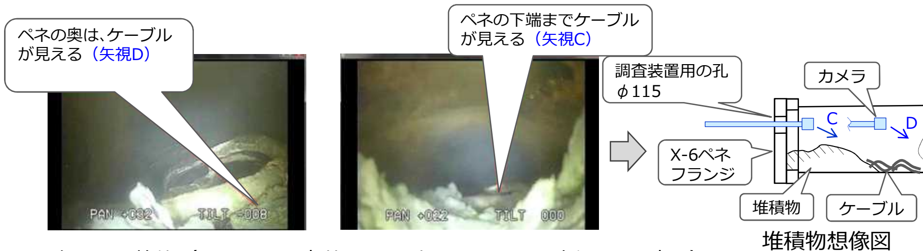
2017年1月の状態 (X-6ペネ調査装置用の孔からカメラを挿入して確認)
