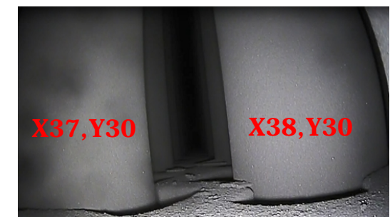
第二管支持板上
