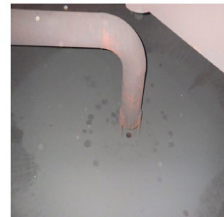
③ SGBDタンク
