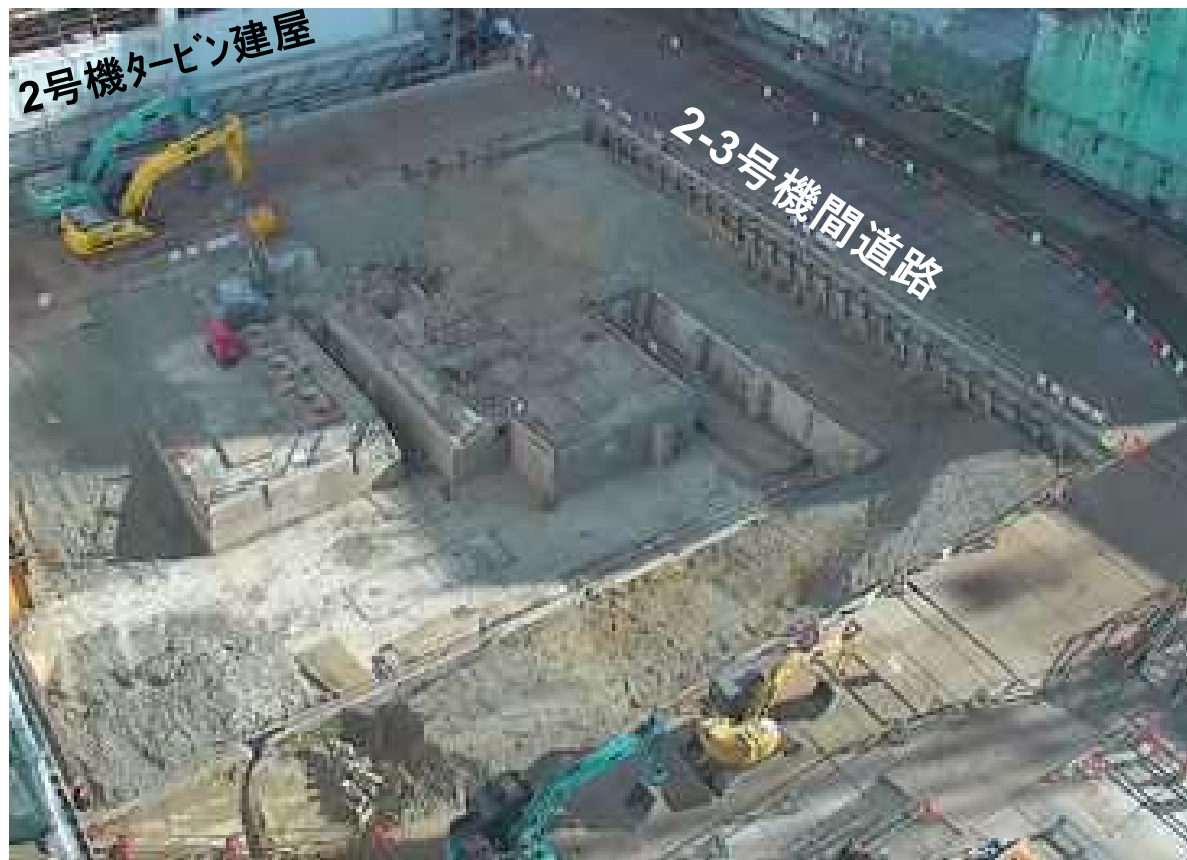
2号機原子炉建屋南側ヤード状況 (2021年1月)
