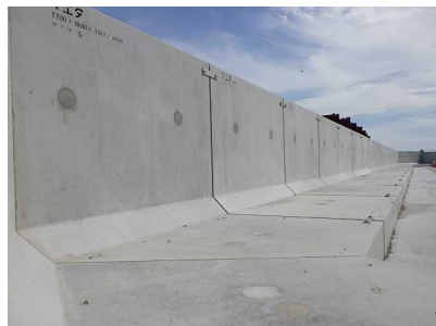
千島海溝津波防潮堤のL型擁壁
