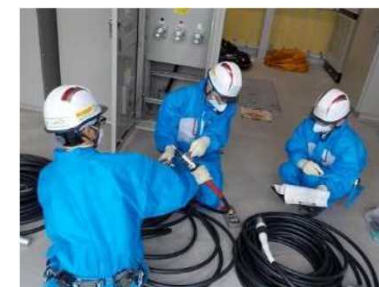
ケーブル導通訓練
