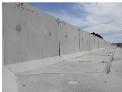
千島海溝津波防潮堤のL型擁壁
