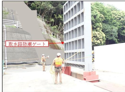
① 取水路防潮ゲートを角落し開口部に挿入した状態から吊り上げ、所定の場所に移動。
