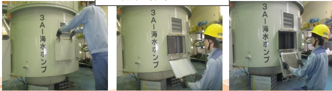
取外し作業イメージ
