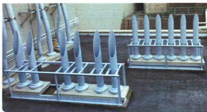
図 3 主蒸気安全弁（排気管）の設置状況（1号炉）
