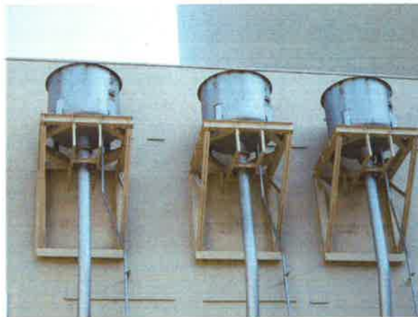
図3 主蒸気逃がし弁消音器の設置状況
