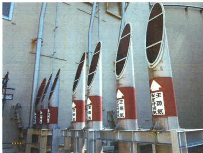
図3 主蒸気安全弁（排気管）の設置状況
