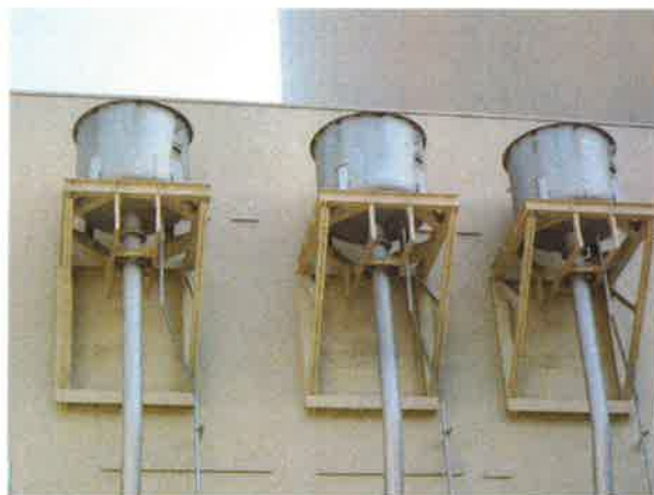
図 3 主蒸気逃がし弁消音器の設置状況
