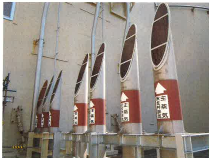
図3 主蒸気安全弁（排気管）の設置状況
