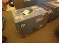
⑦可搬型発電機
