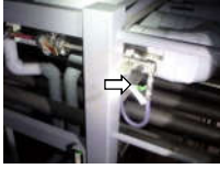
⑤仮設ホース接続
