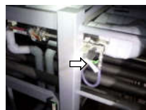
⑤仮設ホース接続
