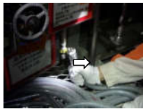
⑥仮設ホース接続
