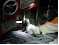
⑥仮設ホース接続
