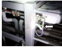
⑤仮設ホース接続
