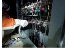
⑥仮設ホース接続
