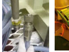
⑦仮設ホース接続
