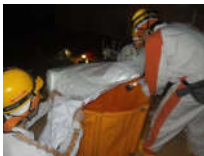
⑧給水作業
