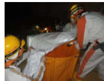
⑧給水作業
