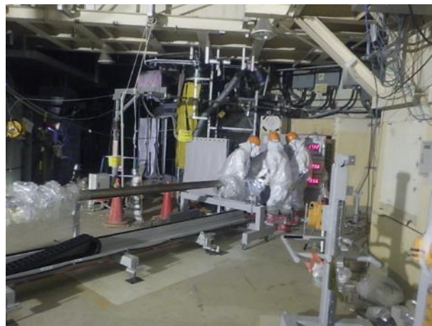
X-6ペネ前での調査装置設置作業
