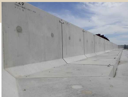
千島海溝津波防潮堤のL型擁壁の据付 (2020年9月25日完了)
