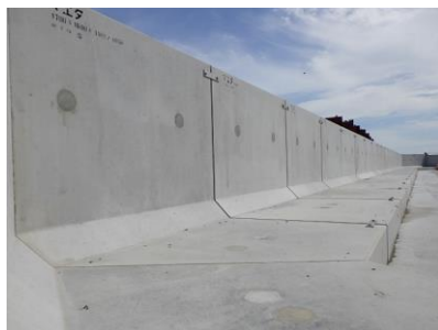
千島海溝津波防潮堤のL型擁壁
