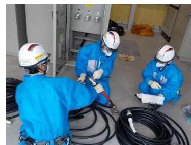
ケーブル導通訓練
