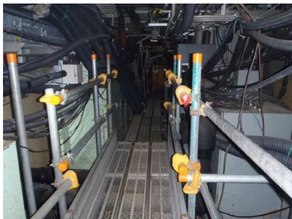
写真1：堰設置予定箇所
