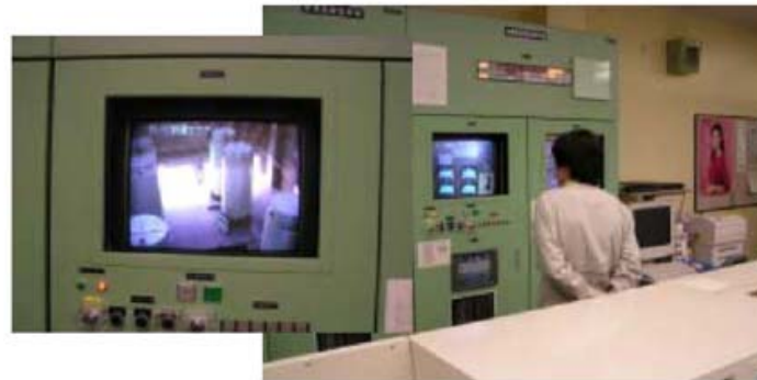
中央制御室 監視盤
