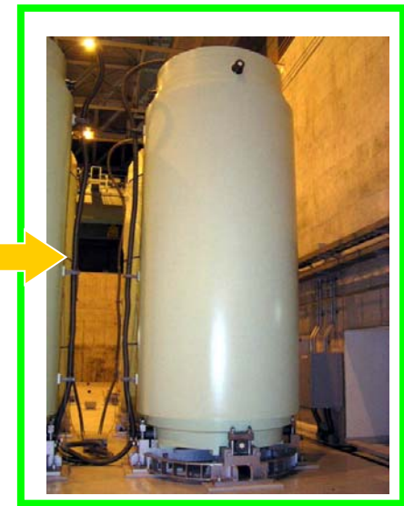
⑥貯蔵建屋へ移送し燃料収納済キャスクを設置
