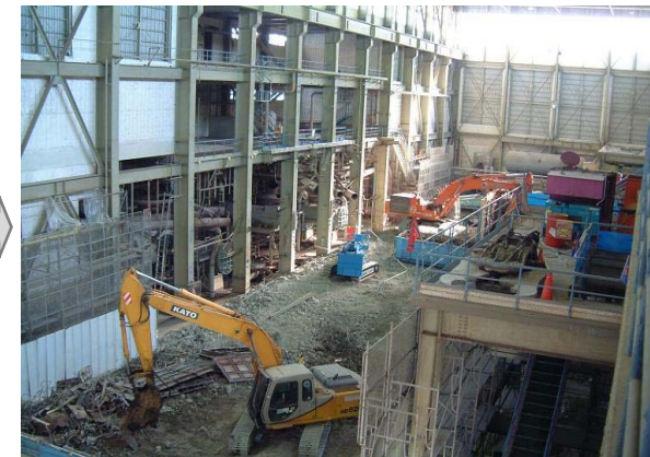
【建屋内機器撤去】
