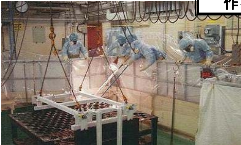
使用済燃料収納ラックの高圧ジェット洗浄作業
