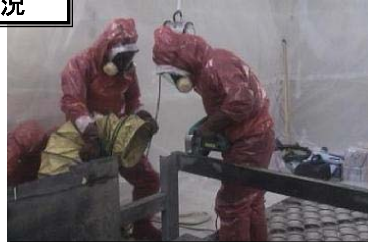
使用済燃料収納ラックの切断作業
