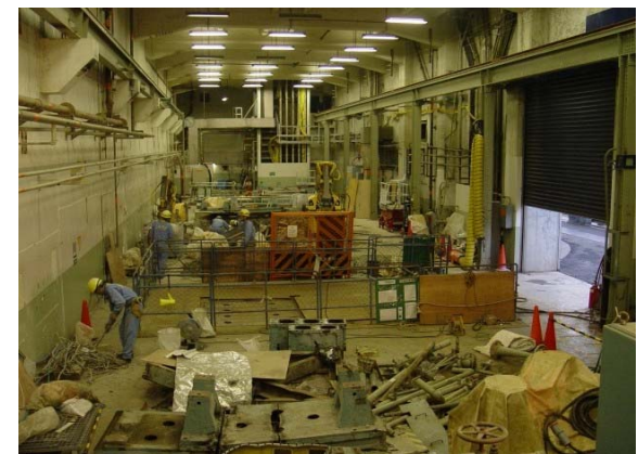
【給水ポンプ室撤去】
