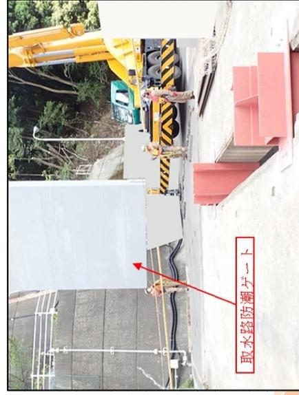
① 取水路防潮ゲートを角落し開口部に挿入した状態から吊り上げ、所定の場所へ移動。
