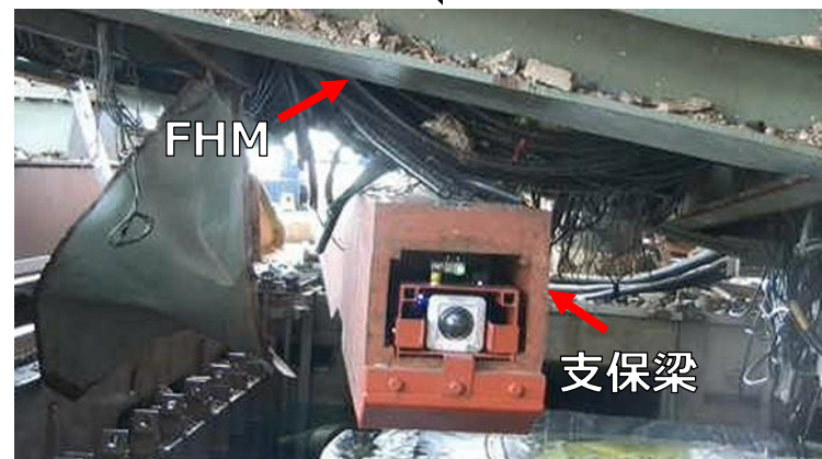
II-a. 支保梁挿入中 (撮影日: 2020.10.20)
