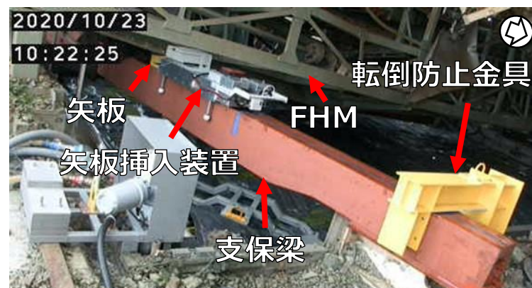
III. 矢板・転倒防止金具設置 (撮影日: 2020.10.23)
