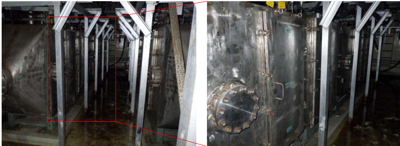
4号機SGTSフィルタトレインの様子
