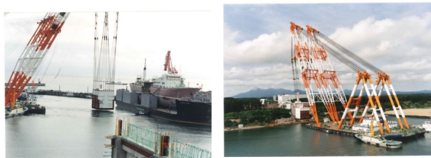
「むつ」の解体工事(平成4年8月～平成8年3月)
