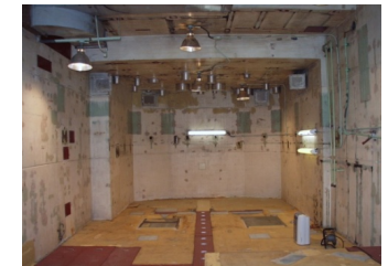
機器撤去後の重水ポンプ室
