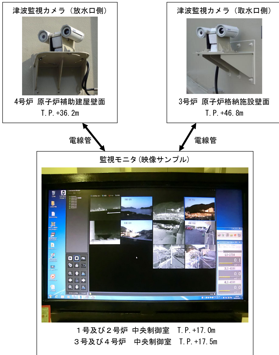
図 3-3-2 津波監視カメラ設備構成イメージ
