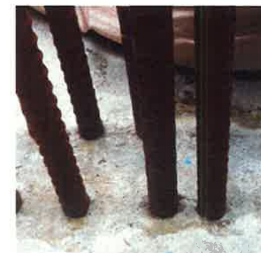
試験体根元部の状況写真
