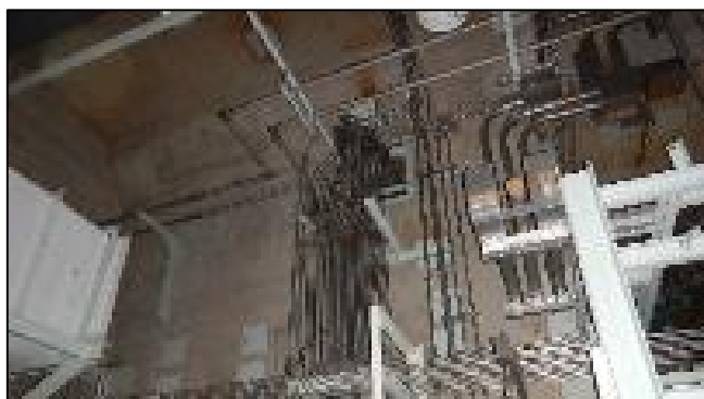
炭酸ガス系配管 (撤去前)
