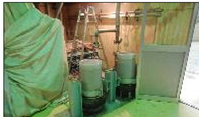
R/B B2F-B1F 逃し安全弁配管 (撤去後)
