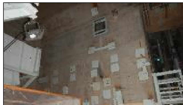
炭酸ガス系配管 (撤去後)
