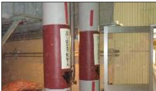
R/B B2F-B1F 逃し安全弁配管 (撤去前)
