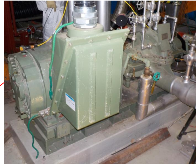
既設FPCポンプの設置状況
