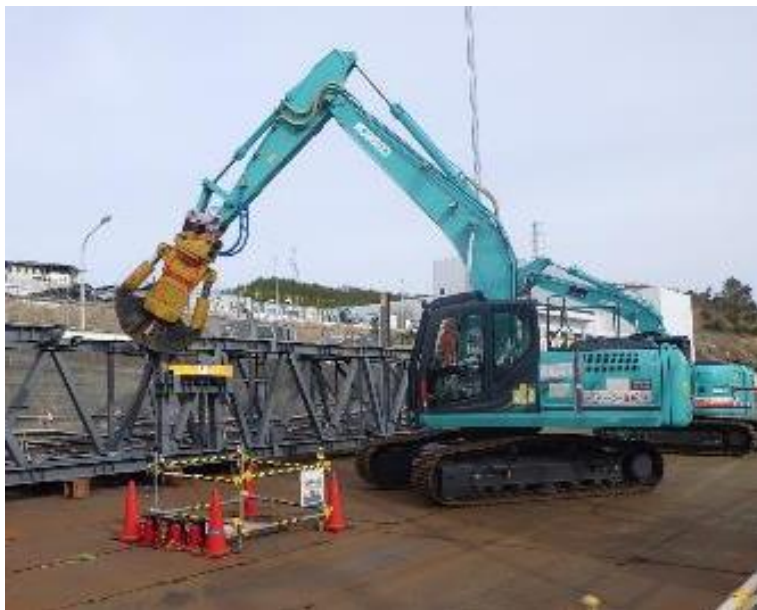
解体重機による小割解体状況
