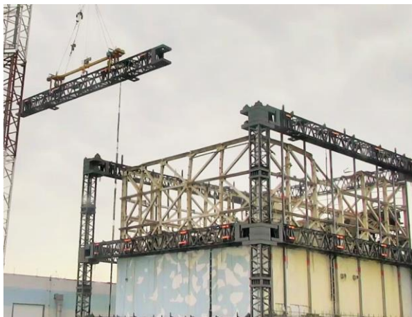
梁取り外し状況
