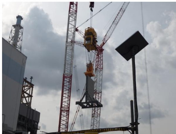
防風フェンス取り外し状況
