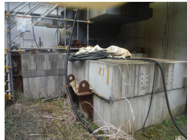
基礎設置状況
