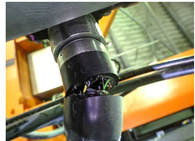
ケーブル断線部
