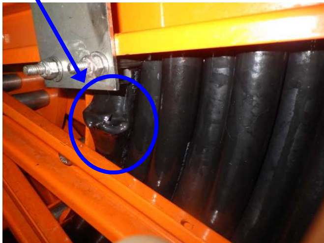
ホース損傷箇所
