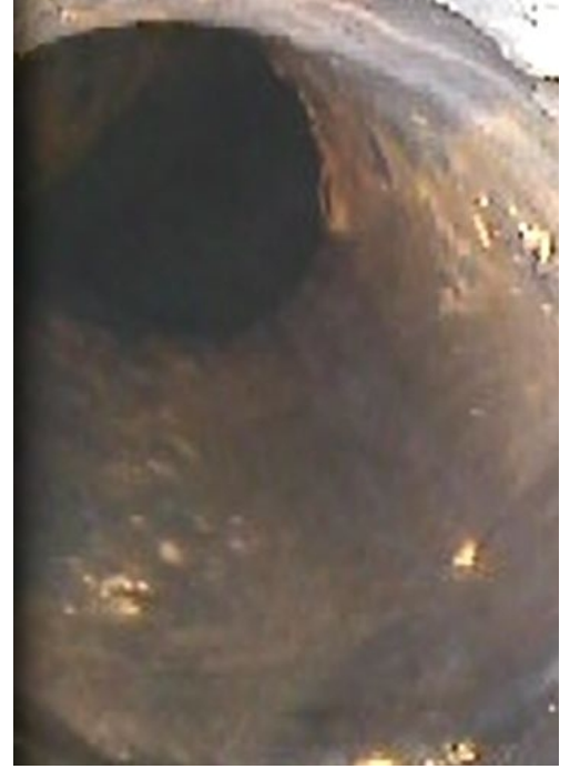
SGブローダウンタンク出口
