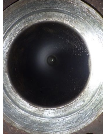
④弁出口管
