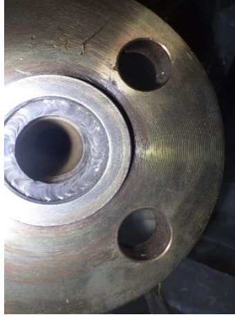
①入口配管
