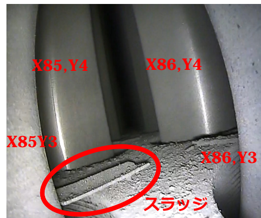
4号機 22回定期検査 スラッジ
