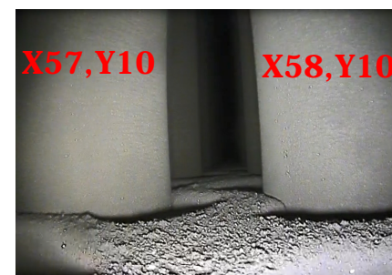
第五管支持板上
