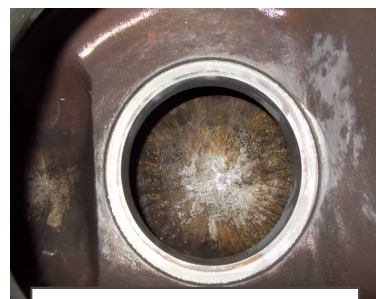
②水位制御弁内部
