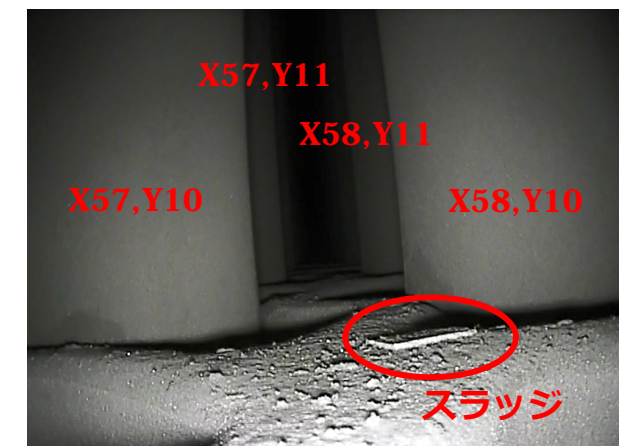
3号機 24回定期検査 スラッジ
