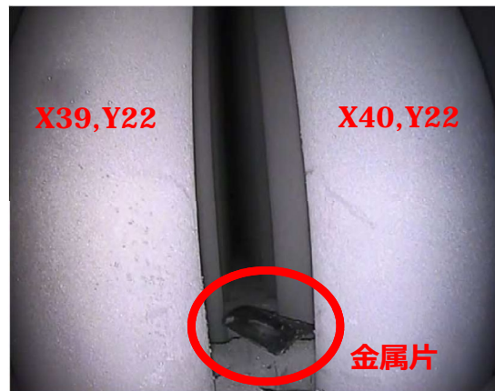
4号機 22回定期検査 金属片
