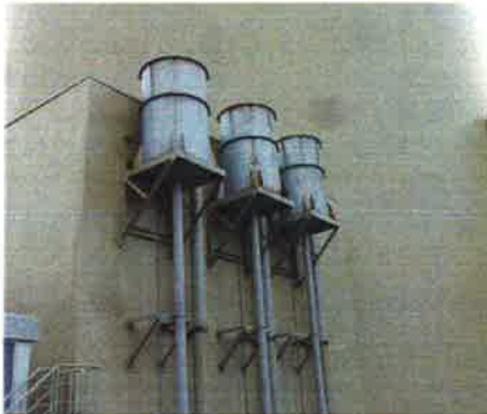
図3 主蒸気大気放出弁消音器の設置状況 (左1号炉、右2号炉 (各3系統))
