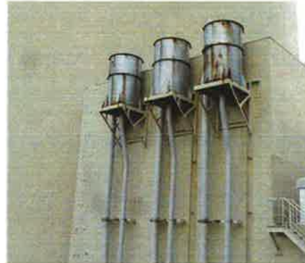
図3 主蒸気大気放出弁消音器の設置状況 (左1号炉、右2号炉 (各3系統))
