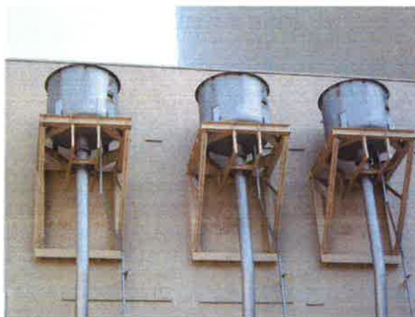
図3 主蒸気逃がし弁消音器の設置状況
