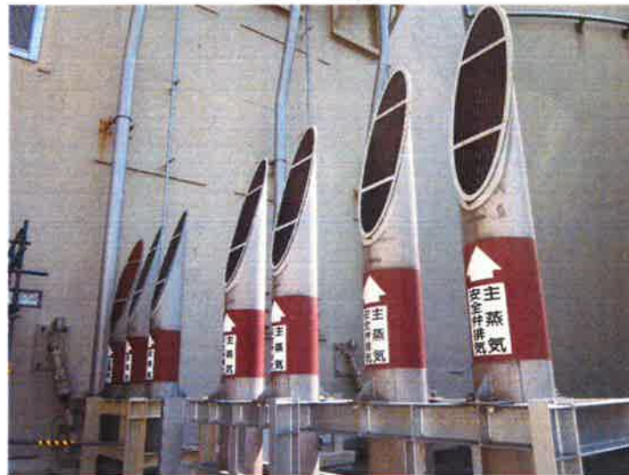
図3 主蒸気安全弁（排気管）の設置状況
