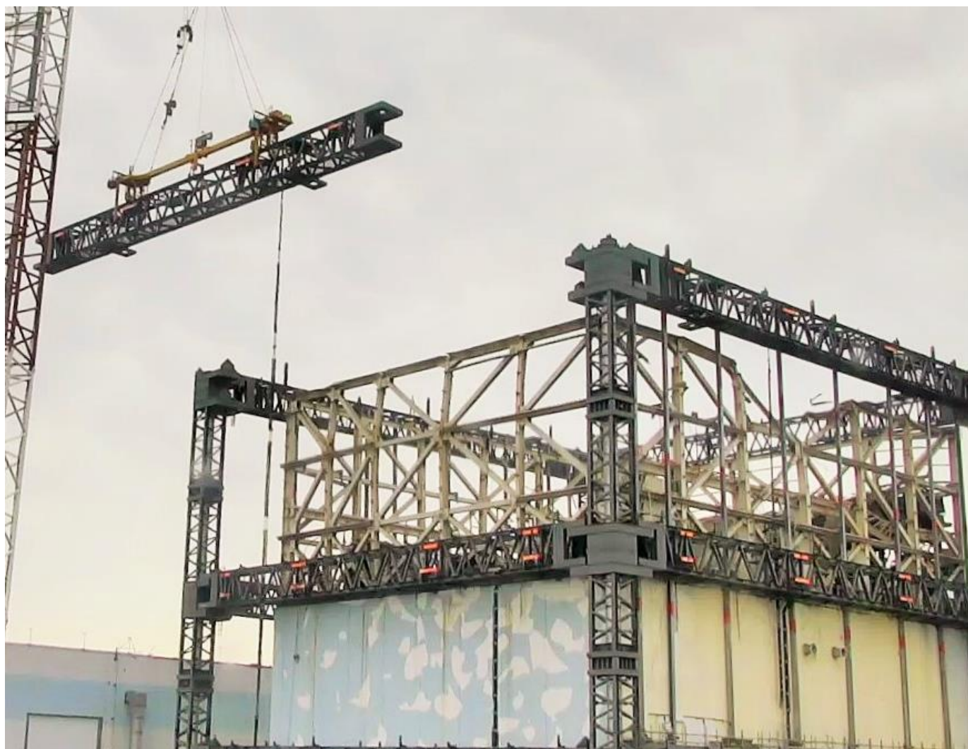
写真 建屋カバー梁解体状況（撮影日：2017.3.31）
