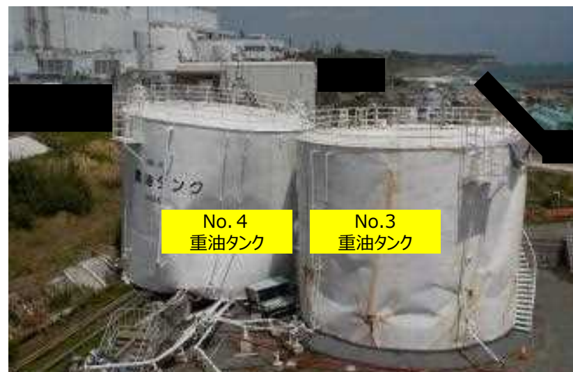
No.3,4重油タンク状況
