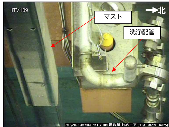
輸送容器洗浄配管との干渉状況 (押し込み後)
