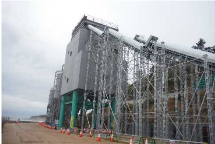
バッチャープラント（構外南側に設置済）
