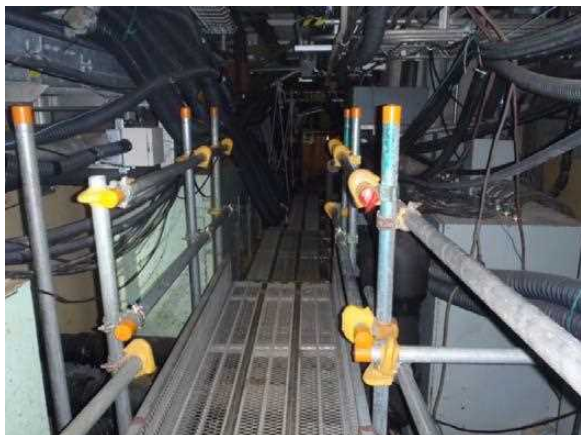
写真1：堰設置予定箇所
