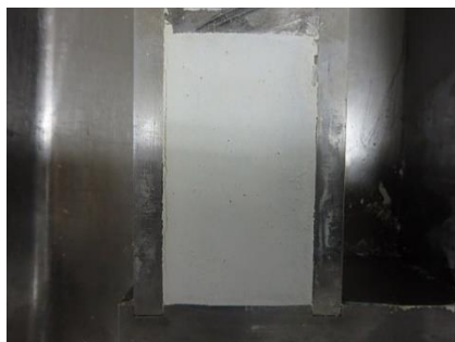
浮き水の有無の確認 (1日養生後)
