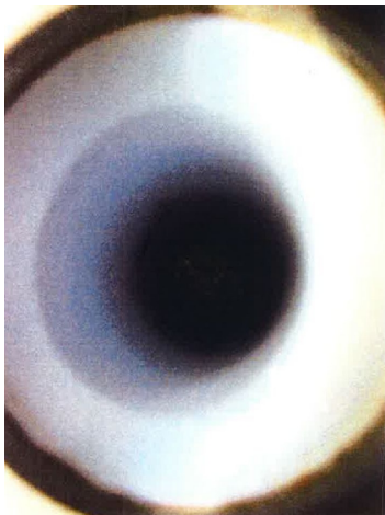
D-SWP潤滑水流量計検出器内部付着物採取
