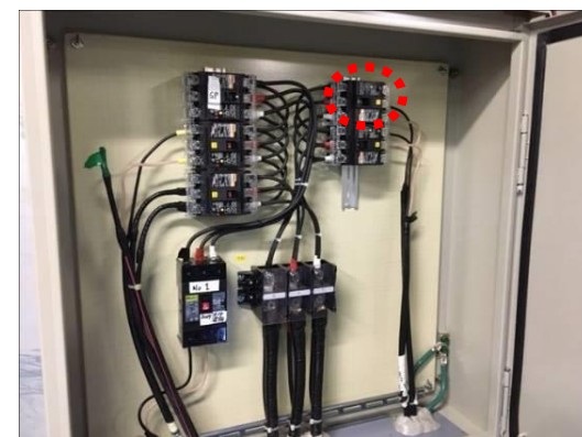
分電盤外観状況
