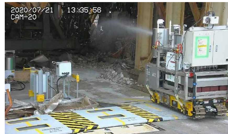
飛散防止剤散布(撮影日:2020.7.21)
