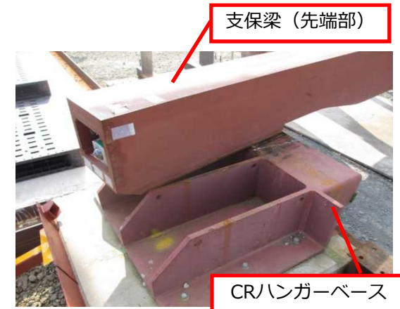
③支保梁挿入 (完了)
