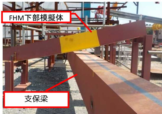
②支保梁挿入
