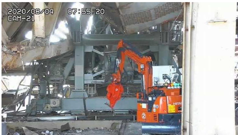
ガレキ撤去作業(撮影日:2020.8.4)
