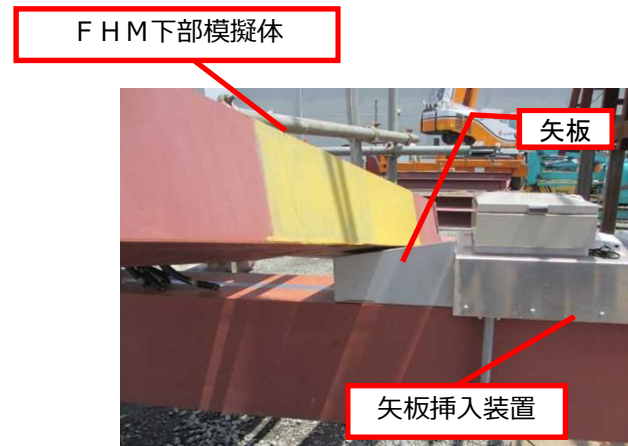
⑤矢板挿入装置自走, 挿入完了
